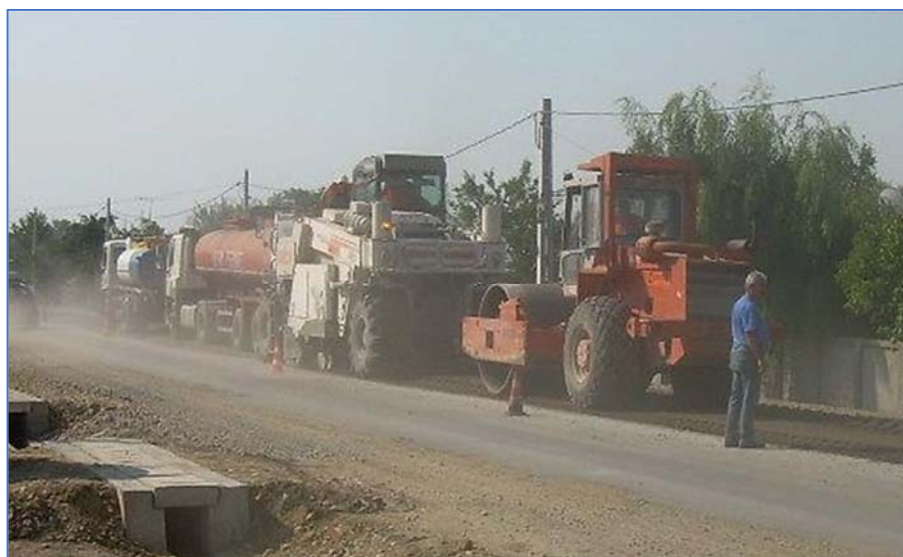
5. ábra Habosított bitumenes hidegremixhez használt géplánc
