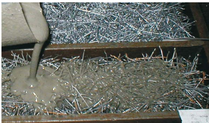
13. kép SIFCON beton készítése[9]
