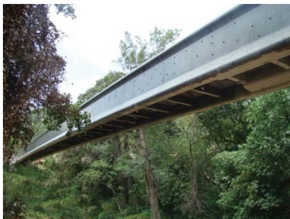
14. kép Az Ördög hídja (Pont du Diable), 1,8 méter magas szerkezet, amely 70 métert (Rudy Ricciotti) hidal át alátámasztás nélkül [10]
