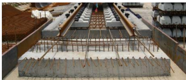
1.5. ábra: Pontszerű alátámasztás
