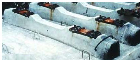
3.1. ábra: Az első, 1972-ben lefektetett Rheda-rendszer [2]
