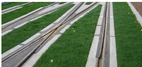
1.6. ábra: Folyamatos alátámasztás
