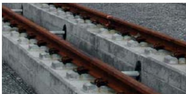
1.3. ábra: Hosszaljas pályaszerkezet
