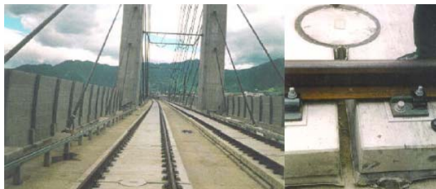
3.8. ábra. Injektált ágyazású, előregyártott betonlemez Shinkansen-rendszer [2]
