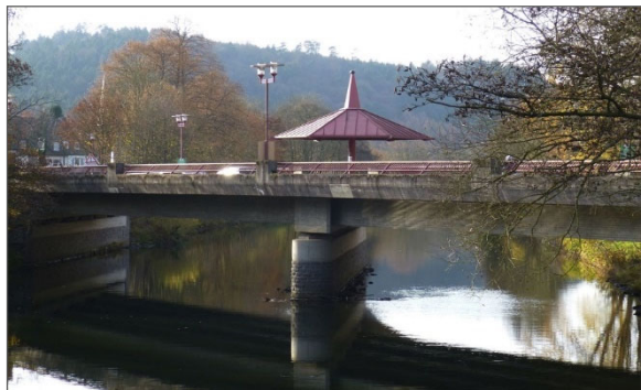
11. ábra Agger brücke
