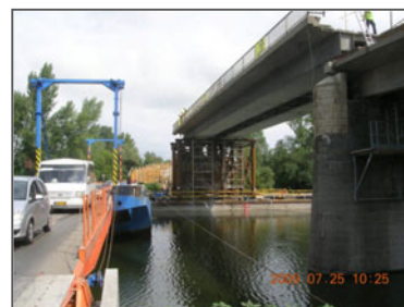
17. ábra Az endrődi Hármaskörös-híd bontás közben
