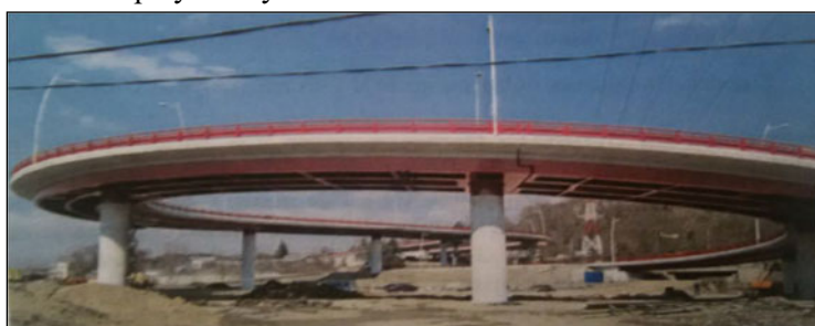
38 – 39. ábra DN1 közúti felüljáró, Campina (2012)
