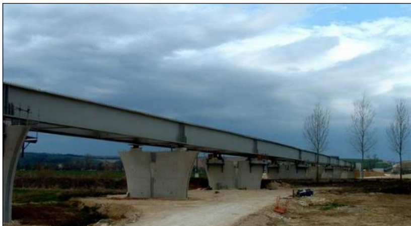
25. ábra Canal de L'Ouest (2005)
