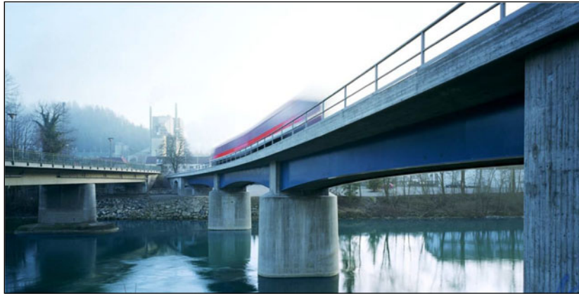
3. ábra VFT típusú híd a Lech folyó fölött Schongaunál, 2001 (Foto: ssf).
