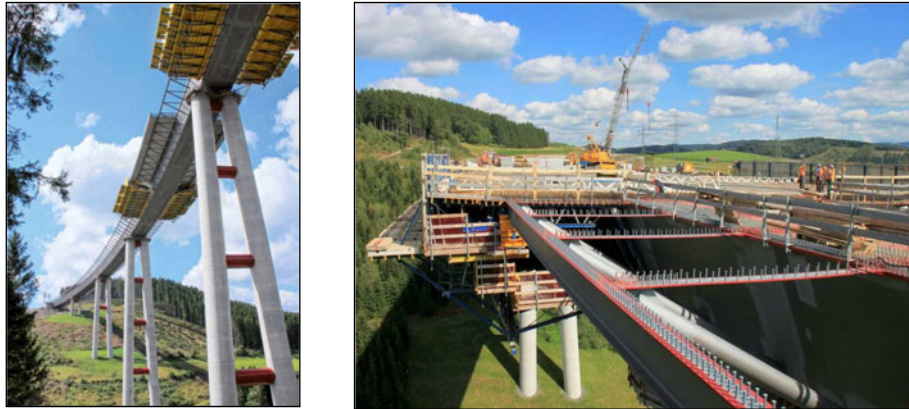
16–17. ábra. Nuttlar viadukt, Nordrhein-Westfalia, A46 Bundesautobahn
