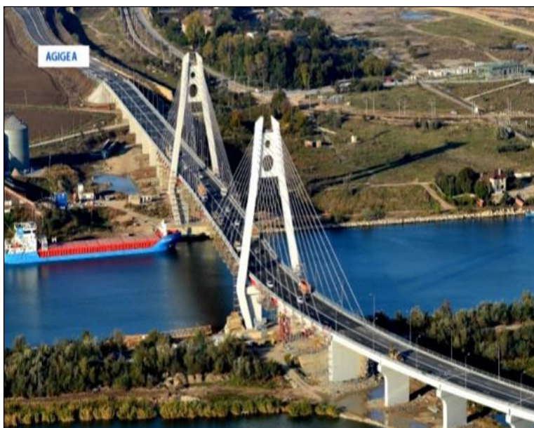
40. ábra Új Agigea híd (2016)
