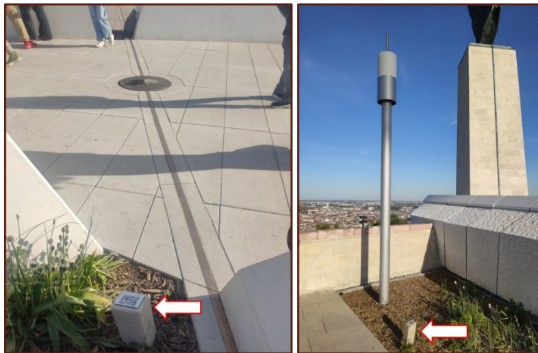
16. ábra. QR-kóddal ellátott oszlopocskák a főpontonál és az új irányzöhengernél
