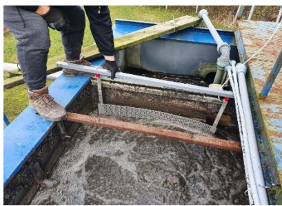
Az elektródák rögzítése
