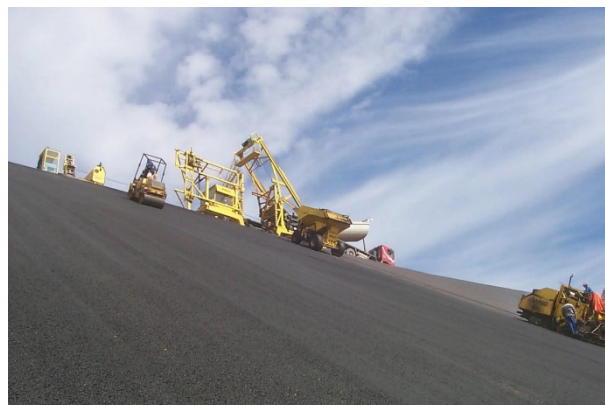
23. ábra: Goldisthal, felső tározó, vízszigetelés megvalósítása
