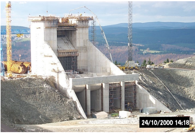
24. és 25. ábra: Felső tározó vasbeton egységeinek a megvalósítása
