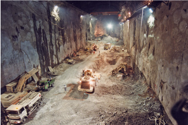
15. ábra: Goldisthal, gépakna kialakítása
