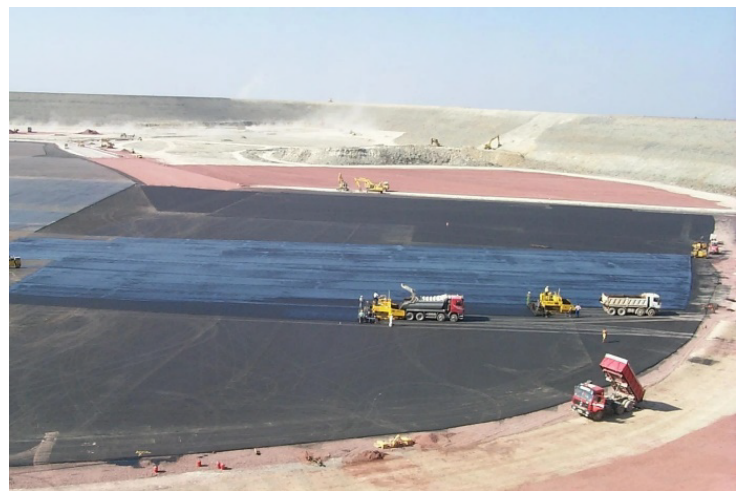
22. ábra: Goldisthal, felső tározó, vízszigetelés megvalósítása
