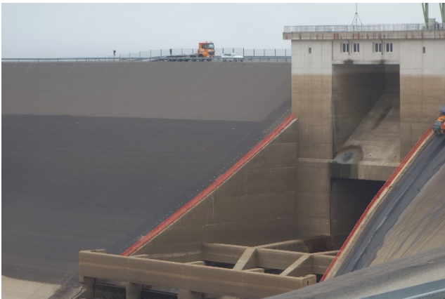
26. ábra: A vasbetonegységek a megvalósítása
