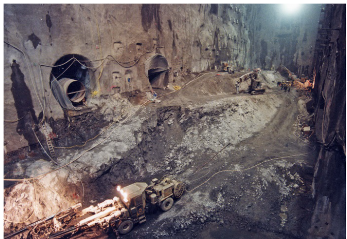
14. ábra: Goldisthal, gépakna megvalósítása
