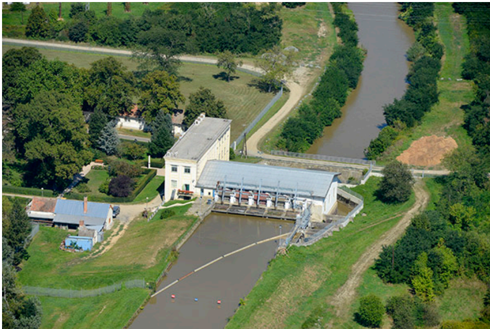
1. ábra. Egy vízerőmű tipikus képe - az Ikervári vízerőmű
