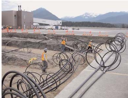
4. ábra Geotermikus rendszer telepítése
