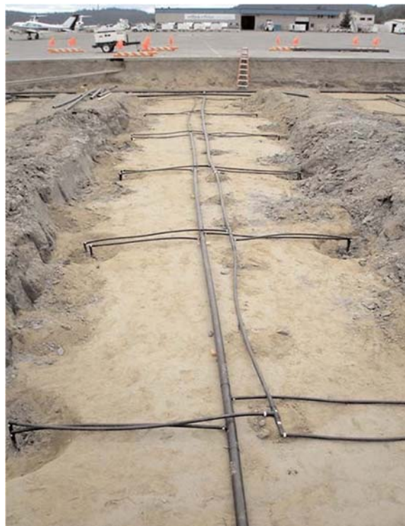
5. ábra Geotermikus „kútmező”. A Juneau Nemzetközi Repülőtér (Alaska, USA) meglévő burkolatai alá telepített kútterek
