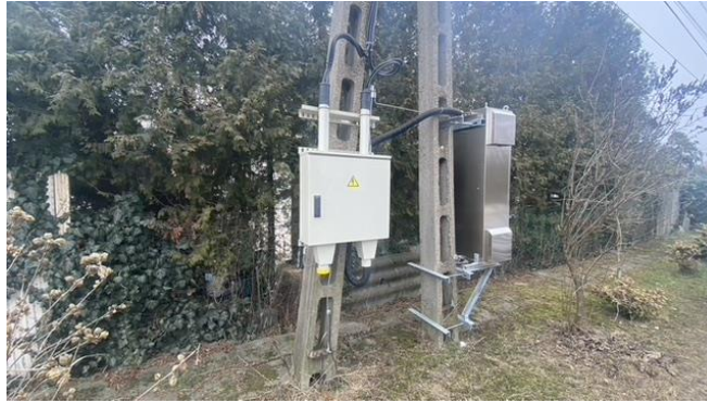
3. ábra Vonalis feszültség szabályozó és sönt szekrény elhelyezése a hálózaton
