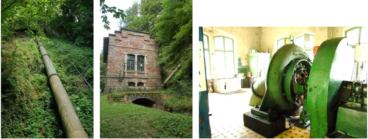
8. ábra: Acéllemez nyomócső – A 'Brázova' erőmű – a működő Ganz gépcsoport 2007-ben
