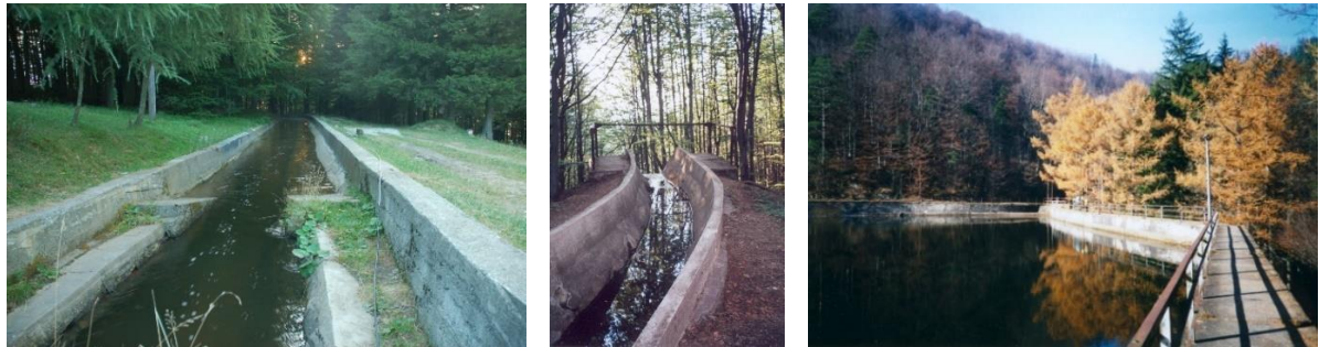
6. ábra: Övcsatorna – faúsztató csatorna – a Berzsava gátja
