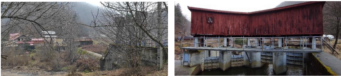
6. ábra: A használaton kívüli gát és a felújított zsilip
