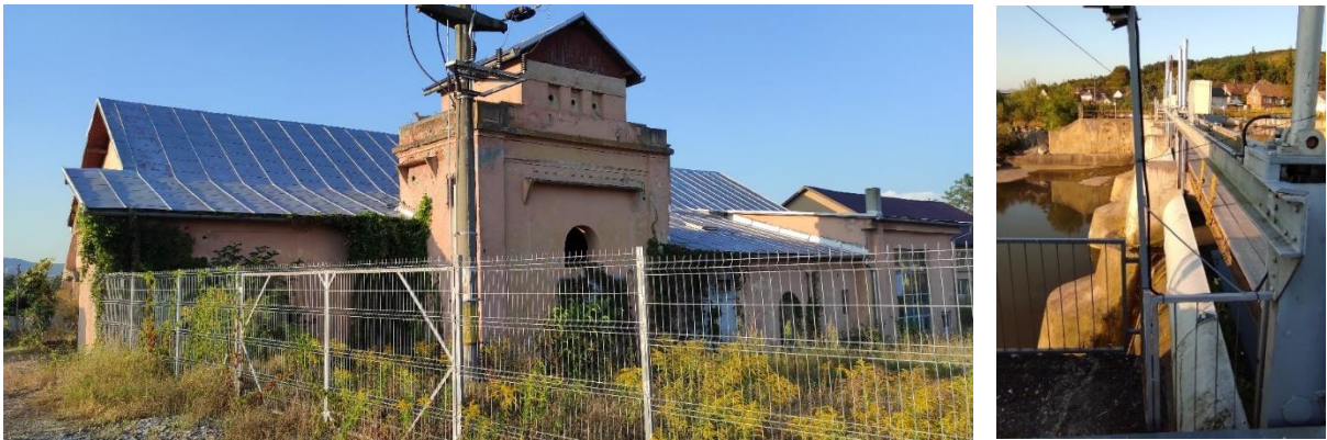
11. ábra: A Dés I. (diesel)gépháza és a duzzasztó
