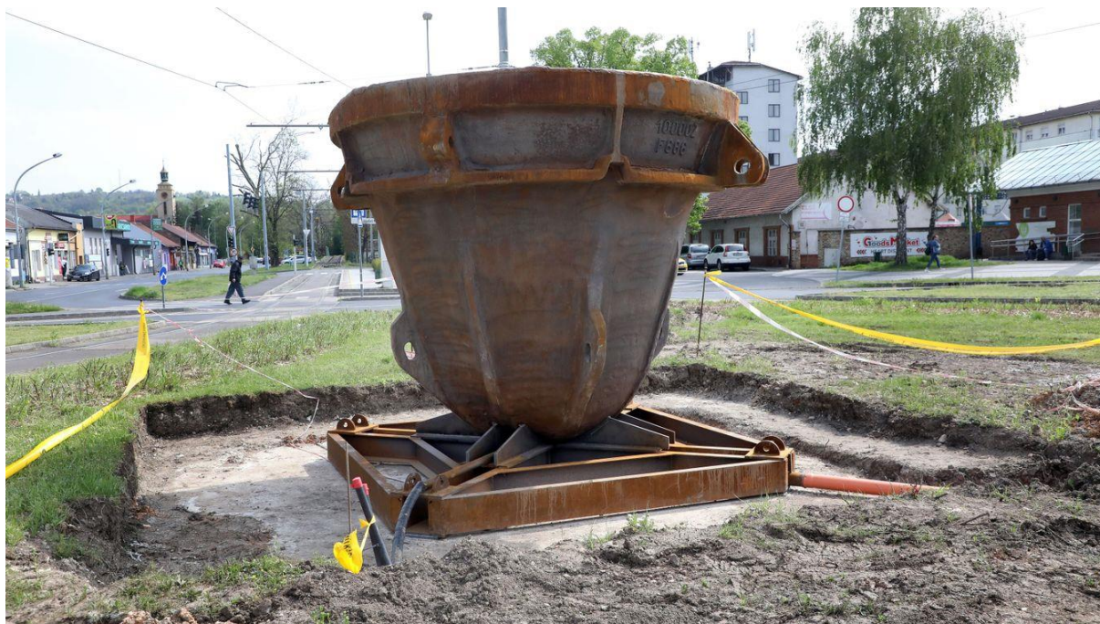
7. ábra Építés közbeni állapot
