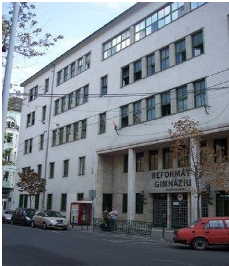
2. ábra. A Lónyai utcai Református Gimnázium épülete. Forrás: wikipédia
