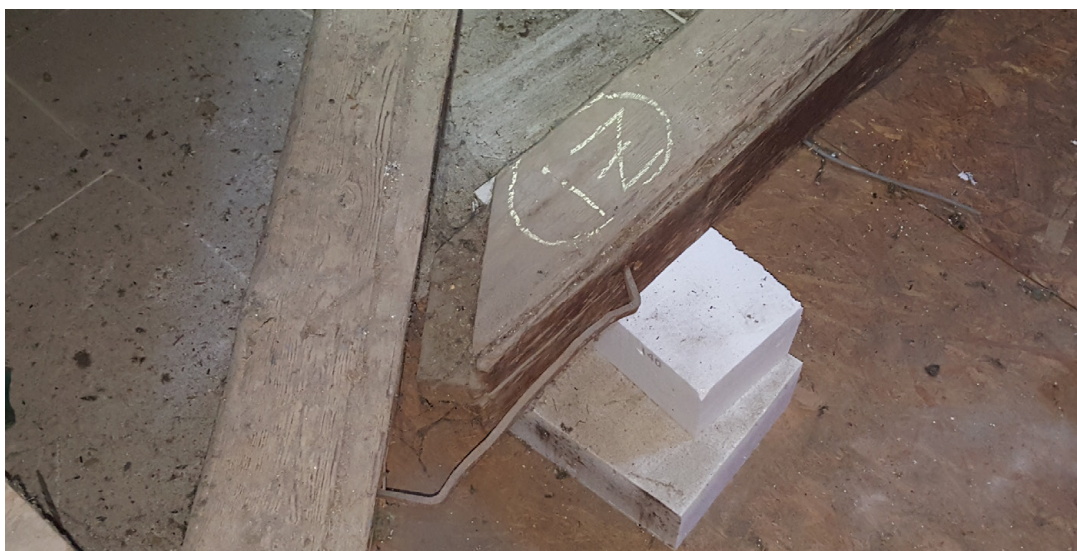
5. ábra. Szétsúszott kötőgerenda csomópont az él főállásnál
