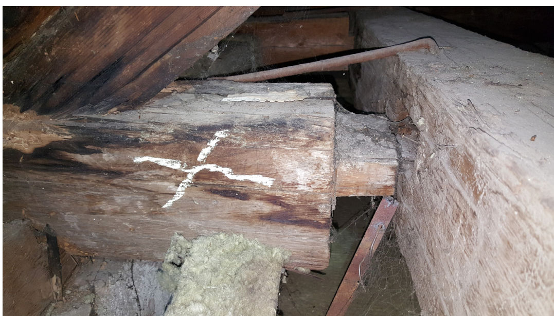
6. ábra. Szétsúszott fiókgerenda – fiókváltó csomópont a kötőgerenda nélküli főállásnál
