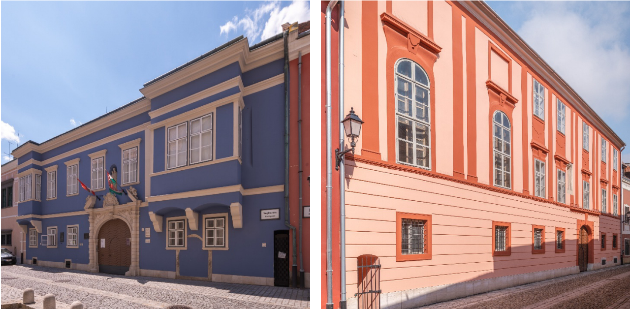
1. ábra. A Sopron, Templom utca 2. és az Új utca 14. számú barokk paloták homlokzatai 2024-ben (Fotó: Tóth Richárd, Tárkányi Sándor)
