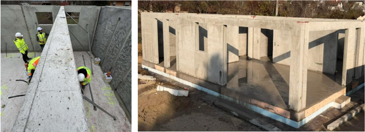
3. ábra. Előregyártott Liapor falpanelek helyszíni szerelési és validációs folyamata
