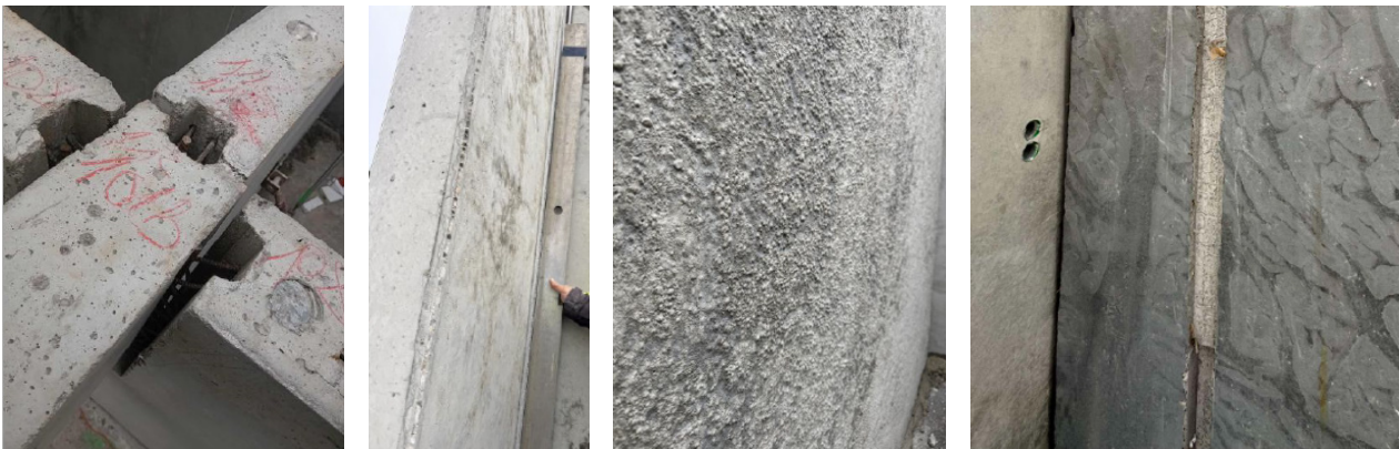
4. ábra. Illesztési és felületi jelenségek dokumentációja a prototípus-fázis tapasztalatai alapján
