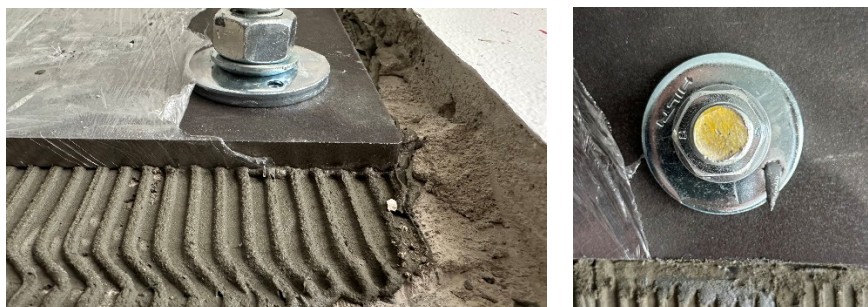
6. ábra. A megerősített kapcsológerenda néhány részlete kivitelezés közben/után
