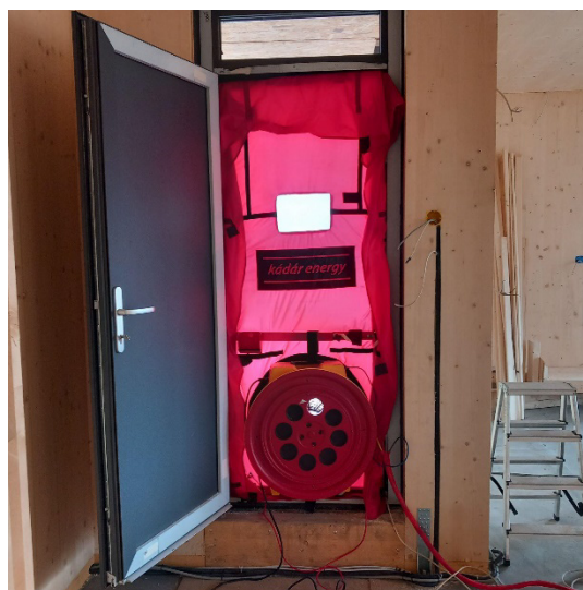
4. ábra. Blower door mérőberendezés telepítése (Fotó: Kádár Ferenc)
