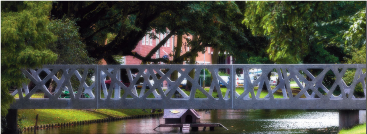
11. ábra. Fenntarthatósági követelményeket is kielégítő díjnyertes UHPFRC Bridge, Rotterdam (2014 fib Awards for outstanding structures - Special mentions).
