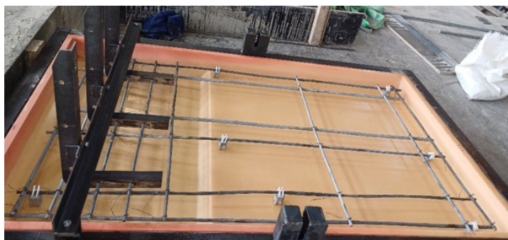
1. ábra. A hídszegély CFCM váza a szilikonsablonban
