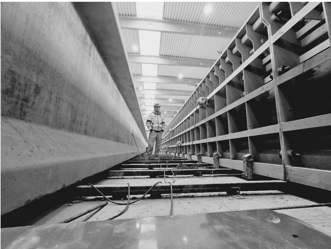
4. ábra. Az elkészült 200 cm magas hídgerenda és a sablonja
