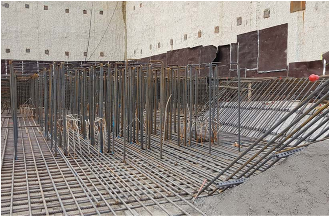
2. ábra. Torony lemezalap vasalása, vasszerelése
