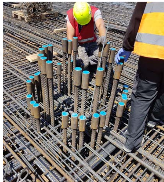
3. ábra. Pászmaátvezetés nagy teherbírású, sűrűn vasalt kör oszlopon
