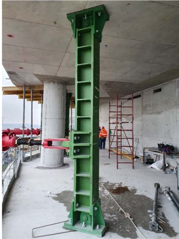
5. ábra. 160 m magas toronydaruk kikötő szerelvénye
