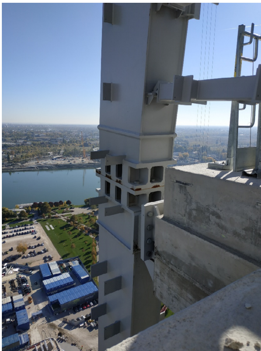
5. ábra. 900x500-as zártszelvény födémcsatlakozási csomópontja
