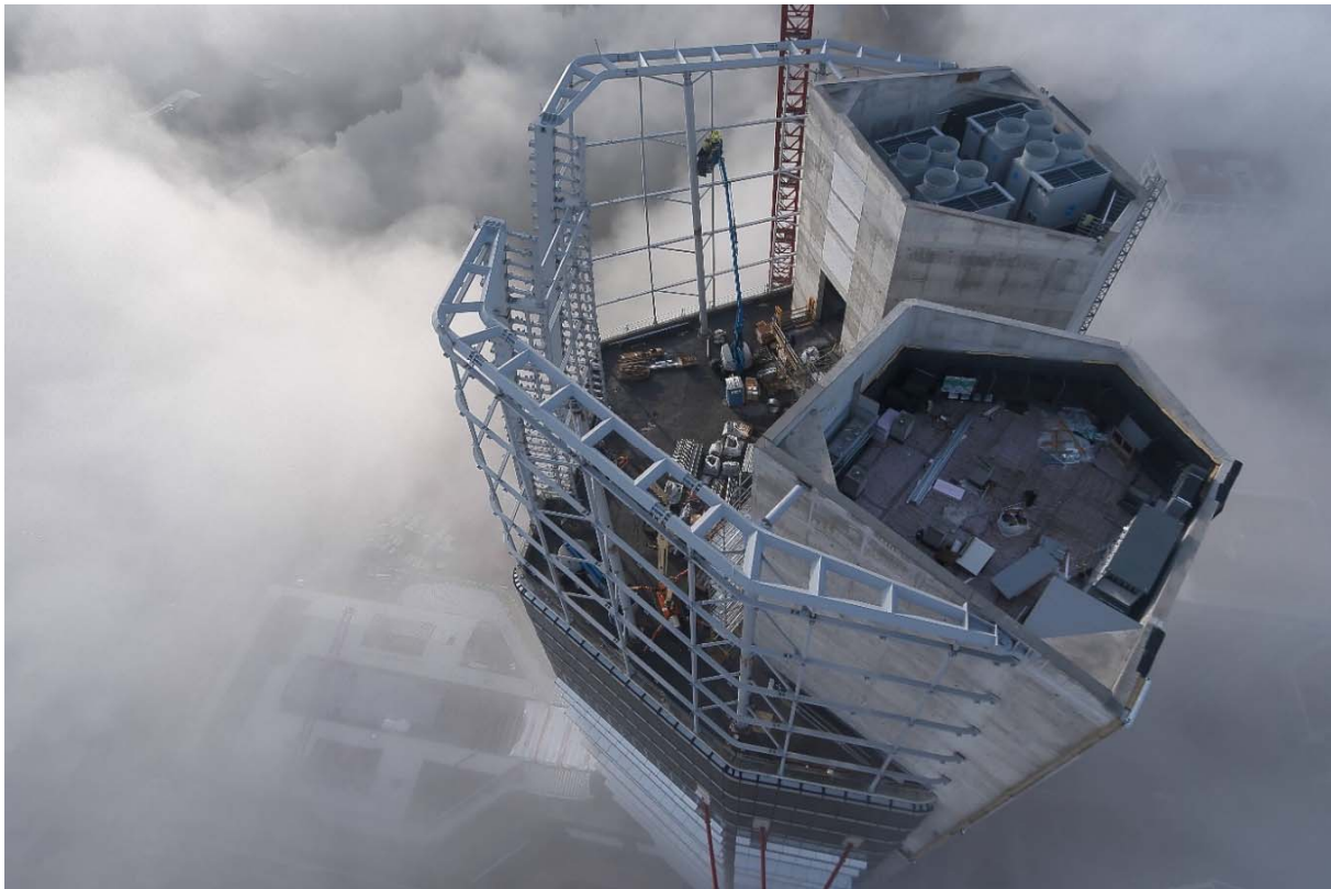
4. ábra. Korona acélszerkezete szerelési állapotban
