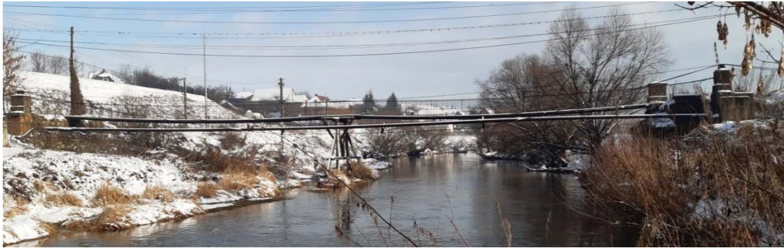
2. ábra. A megmaradt hídfők és az őket utólagosan összekötő gyalogoshíd.
