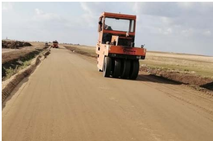
6. ábra Szemcsés anyag statikus tömörítése gumihengerrel: DJ693, Temes megye
