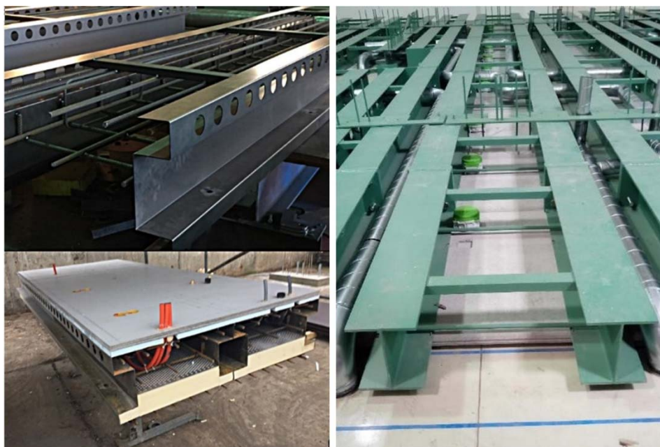
6. ábra. Fal- és födémelem előszerelése
