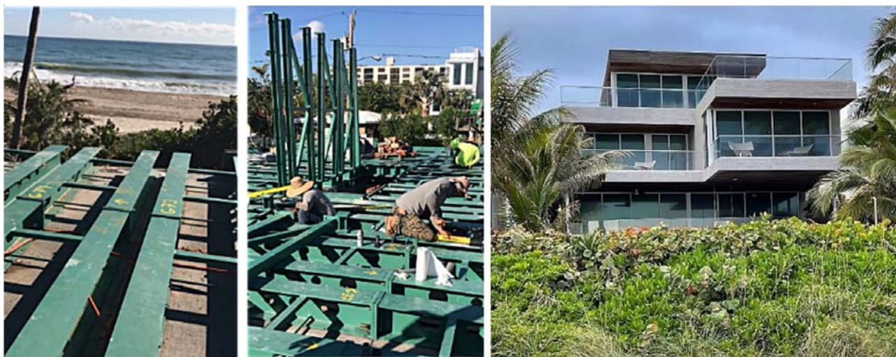
9. ábra. Födém helyszíni szerelése és a szerkezetkész épület az óceán felől nézve
