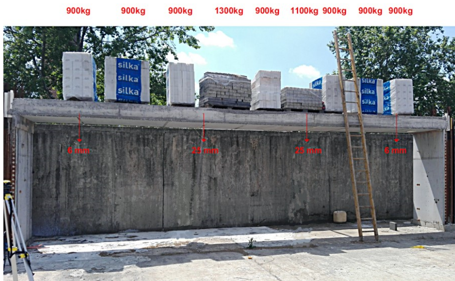
7. ábra. Fal- és födémelem előszerelése, födém próbaterhelése
