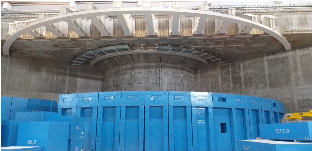
5. ábra. A bunker dél-keleti oldala [A szerző saját felvétele]
