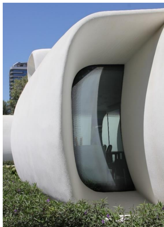
9. ábra. A világ első 3D betonnyomtatással készült irodaépületét Dubai központjában toronyházak közötti parkban helyezték el
