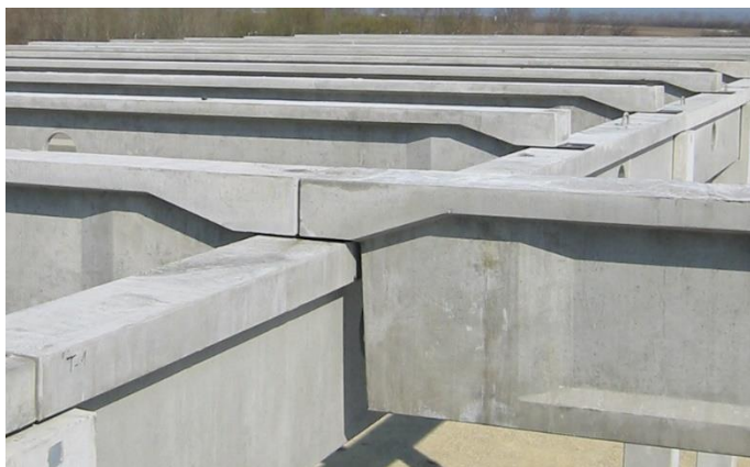
6. ábra. Előregyártott vasbeton keretszerkezet csomópontja
