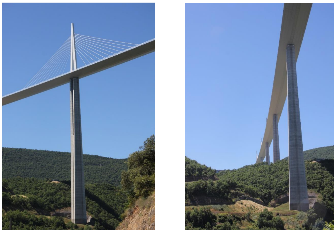
8. ábra Millau viadukt
