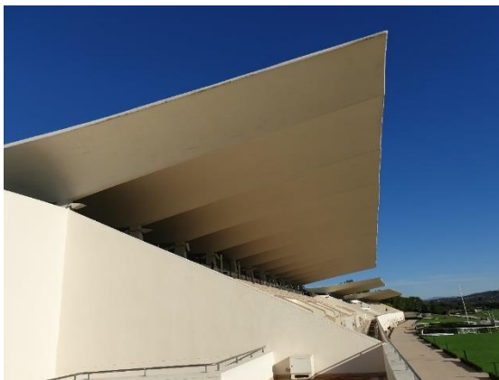
4. ábra. A madridi Zarzuela ügetőpálya lefedése (Eduardo Torroja, épült 1935)
