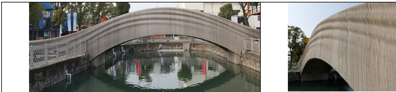
10 ábra. 3D nyomtatott betonhíd, Sanghaj, Kína (Dixon, 2019; Ravenscroft, 2019)
