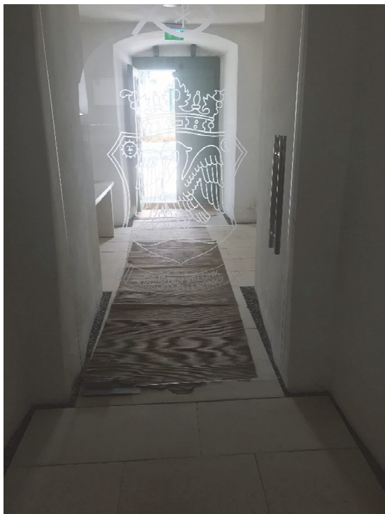
9. ábra. A helyreállított portikusz
