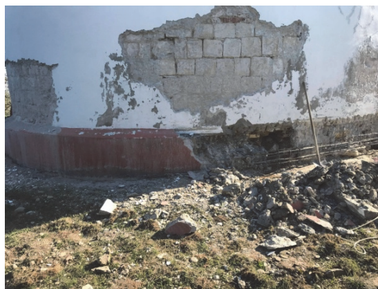
4. ábra. Parazita vasbeton elemek
