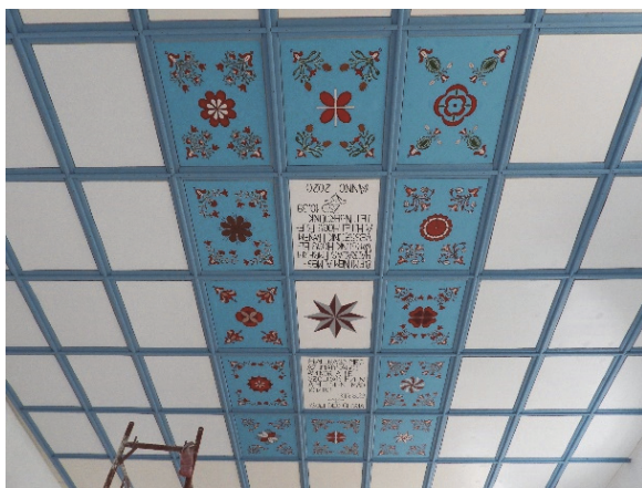
7. ábra A helyreállított kazettás mennyezet
