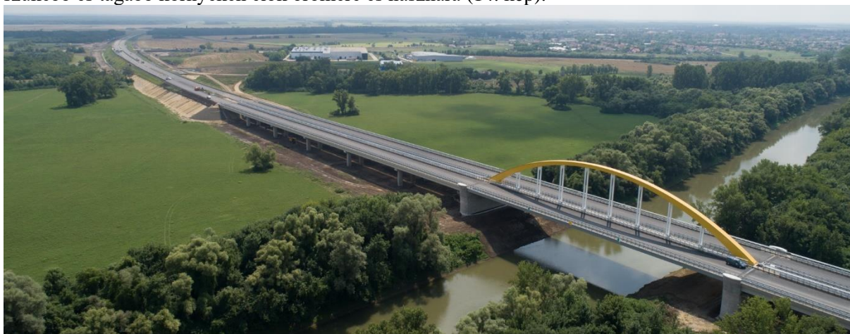
14 kép Az elkészült Berkó-híd
