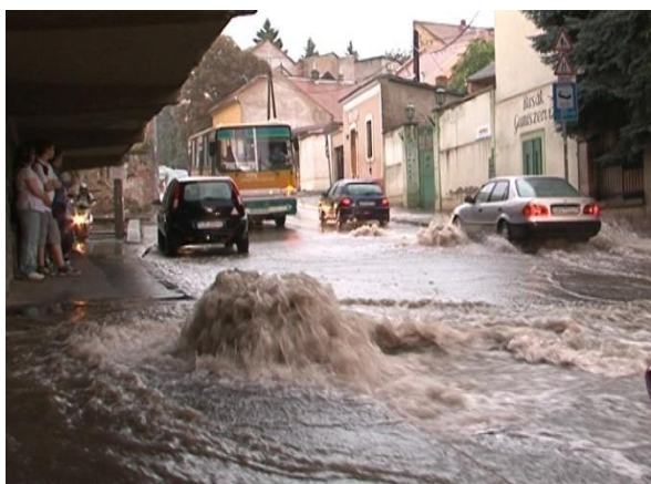
3. kép A csatornahálózat túlterhelésének következménye[7]
