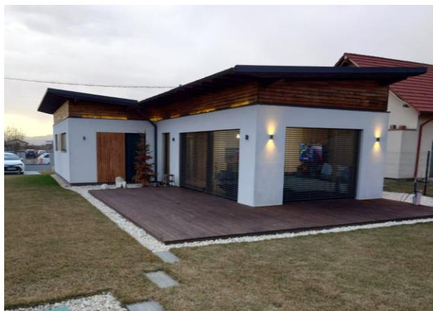
8. ábra C. épület – fotó Szilveszter Szabolcs
