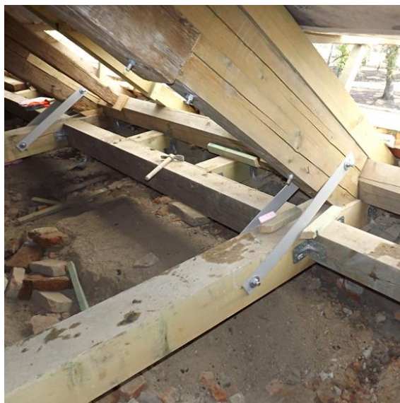
6. ábra. Statikai kiviteli terv csomóponti részlet és a megvalósult állapot képe [a szerző felvétele]
