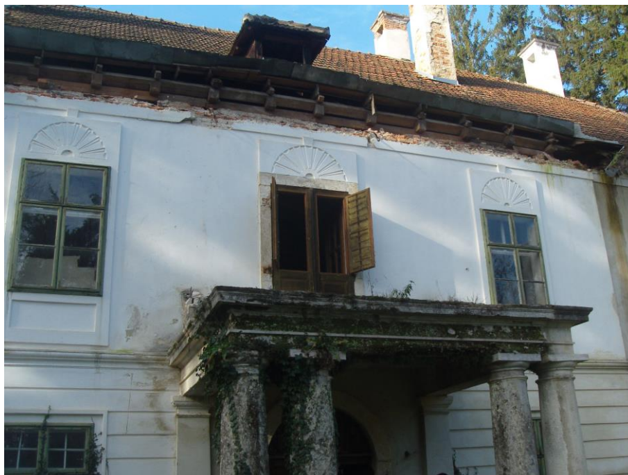
2. ábra. A tömördi Chernel-kúria főhomlokzata 2017-ben, a középrizalit párkányzatának és attikájának leomlása után [a szerző felvétele]
