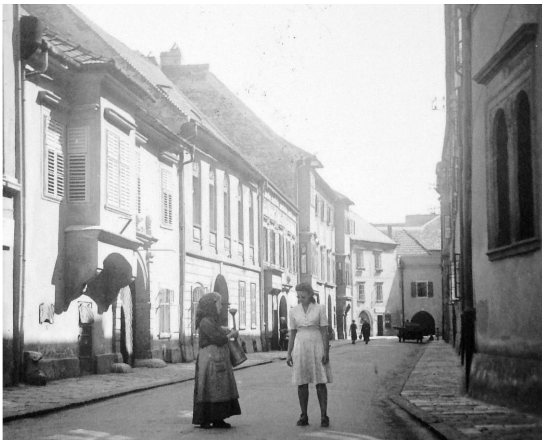
1. ábra. A Kolostor utca 5. sz. épület homlokzata 1942-ben (a kép bal oldalán) [4]
