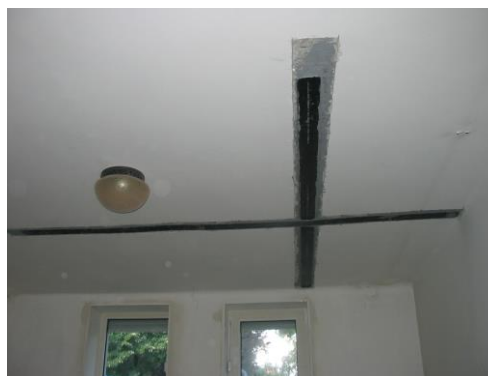
Kivágott födémek megerősítése Temesvár (2007)
