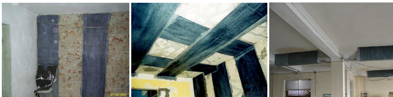
Tégla falak megerősítés Újmoldova (2003)
