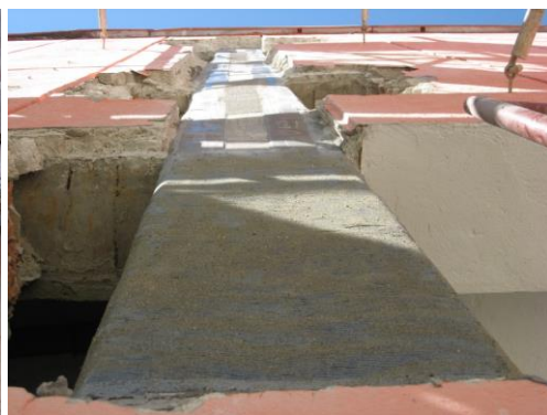
Keretszerkezet megerősítése Temesvár (2010)
