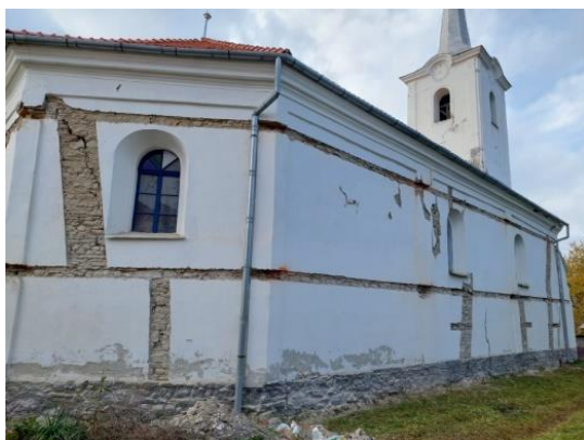
5. ábra: Vakolatbontások Geosteel G 200 háló Geocalce Antisismico habarcsba ágyazása előtt
