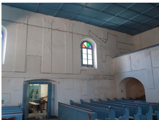
7, 8. ábra: A belső erősítőszávok (Geosteel G 200 alul és Helibar 6mm; Brutt Saver 8mm felül) bedolgozása után
