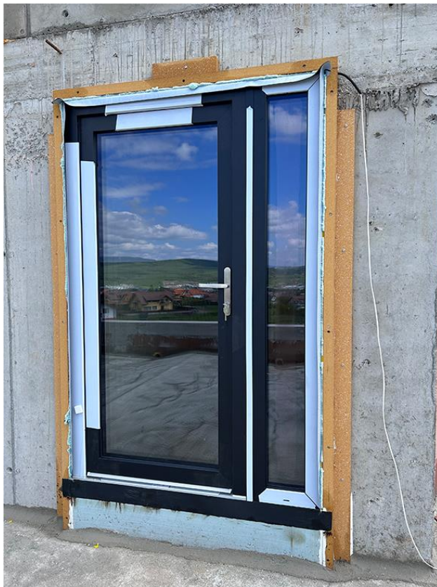
2. ábra: Purenitből készült előkeretes teraszajtó beépítés kivitelezés közben
