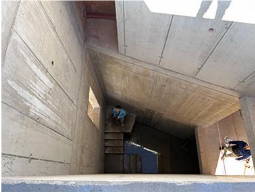
3. ábra: Az elkészült látszóbeton lépcsőház
