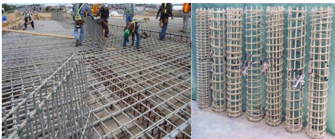
3. ábra. FRP hídpálya építés közben (balra) [8] és FRP cölöp armatúra (jobbra) [10].
