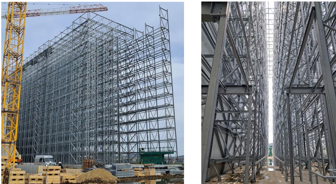
1. ábra. Magasraktár épület hidegen hajlított acélidomokból
