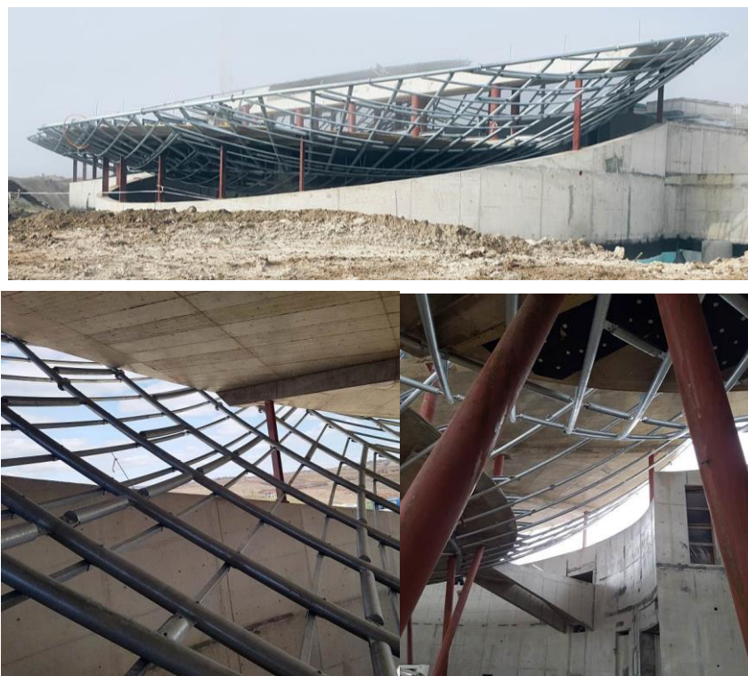
9. ábra. Az acélszerkezet szerelés közben
