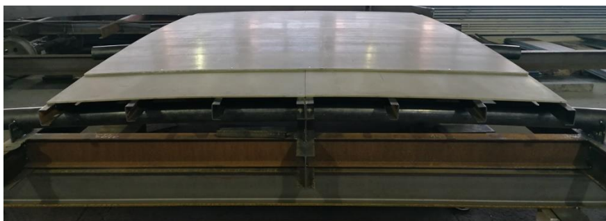
8. ábra. A primer tartóváz gyárban történő sablonra szerelése
