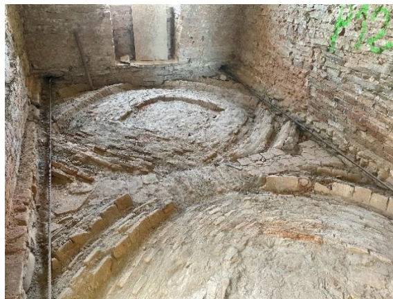
12-13. ábra. Tükörcboltozatok feltárása, megerősítése
