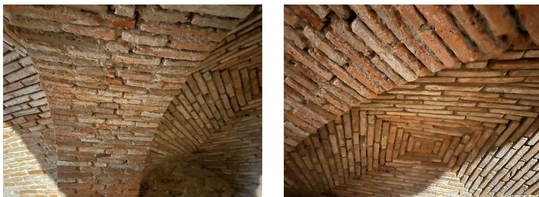
2–3. ábra Alagsori boltozatok megerősítése
