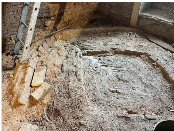
12-13. ábra. Tükörcboltozatok feltárása, megerősítése
