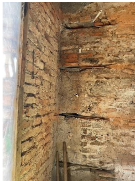
6-7. ábra. Sarok falkötések spirál szálakkal, injektálással
