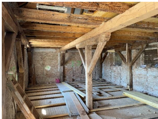
4-5 ábra. Eredeti és új tartószerkezetek összeillesztése
