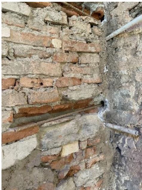
6-7. ábra. Sarok falkötések spirál szálakkal, injektálással
