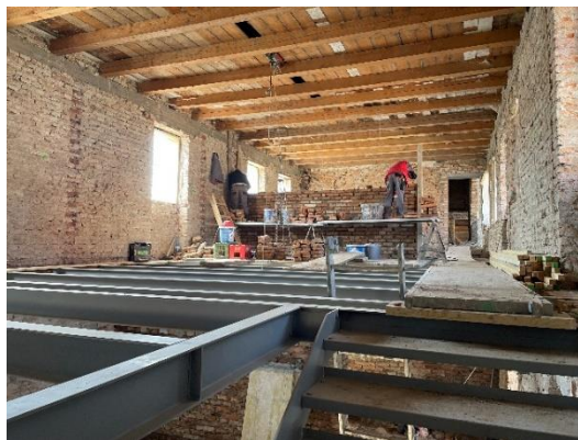
4-5 ábra. Eredeti és új tartószerkezetek összeillesztése
