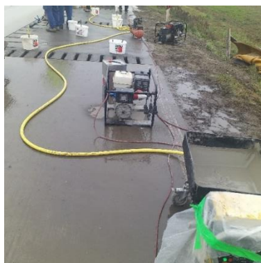
9. ábra Az injektálás folyamata (szf)
