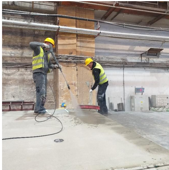
2. ábra. A felület kialakítása (szf)
